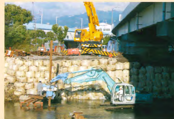
樹木下、河川内施工
