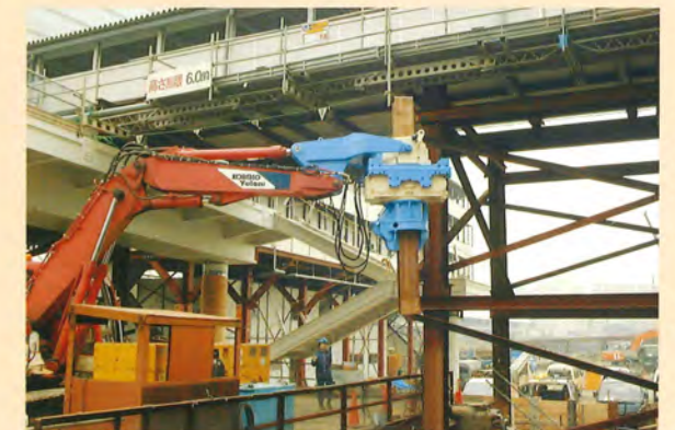
桁下、狭隘地施工
