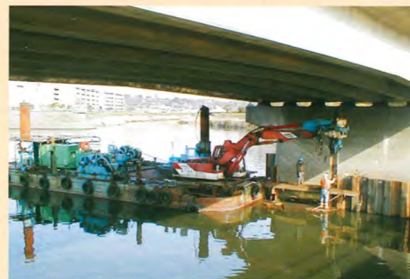
桁下、水上施工
